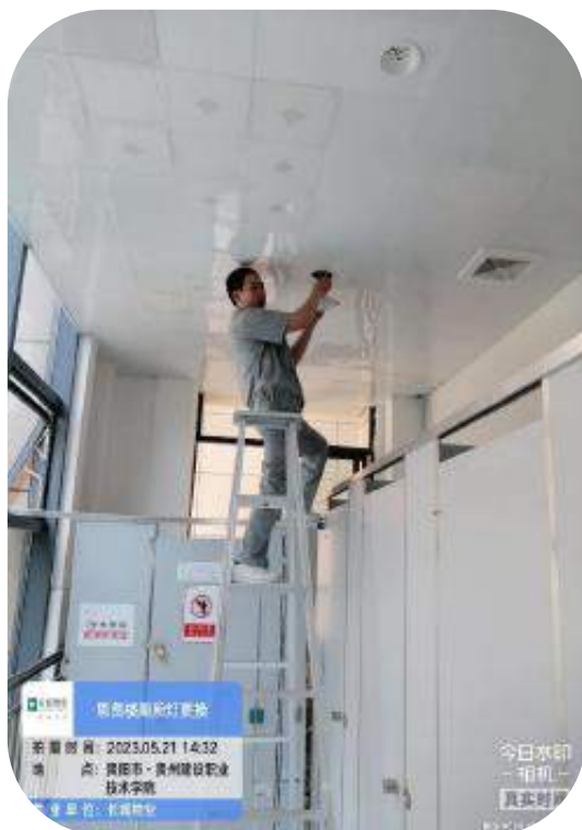
思贤楼卫生间照明更换
