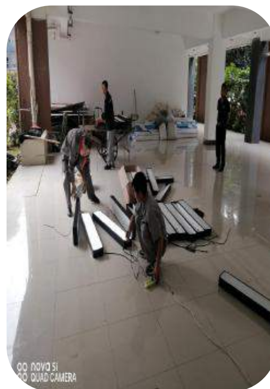
利旧灯管维修
