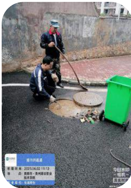
配合外单位疏通排污井
