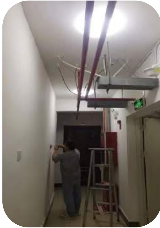
公租房照明维修
