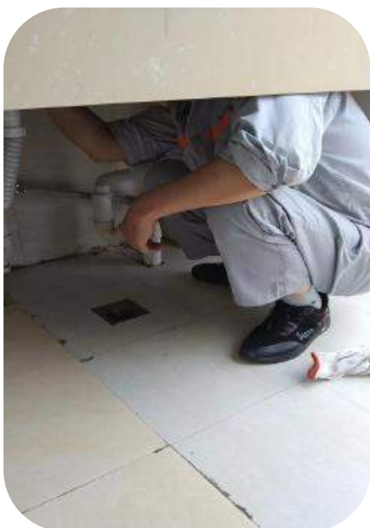
宿舍楼排水管疏通
