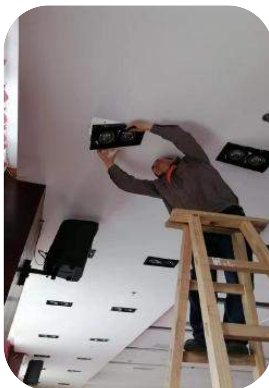
图书馆照明灯具更换
