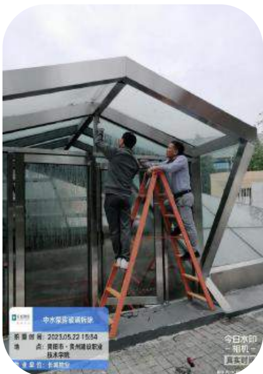
中水泵房拆除玻璃散热
